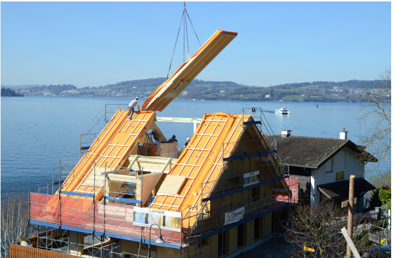
Helikoptermontage Wohnhaus in Endphase
