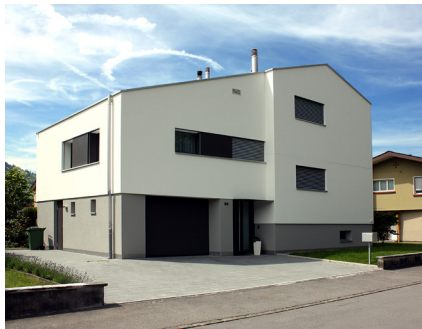
Ansicht von der Strasse
