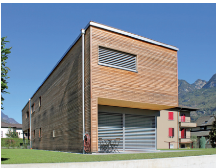
Die Südfassade und die langgezogene Westfassade
