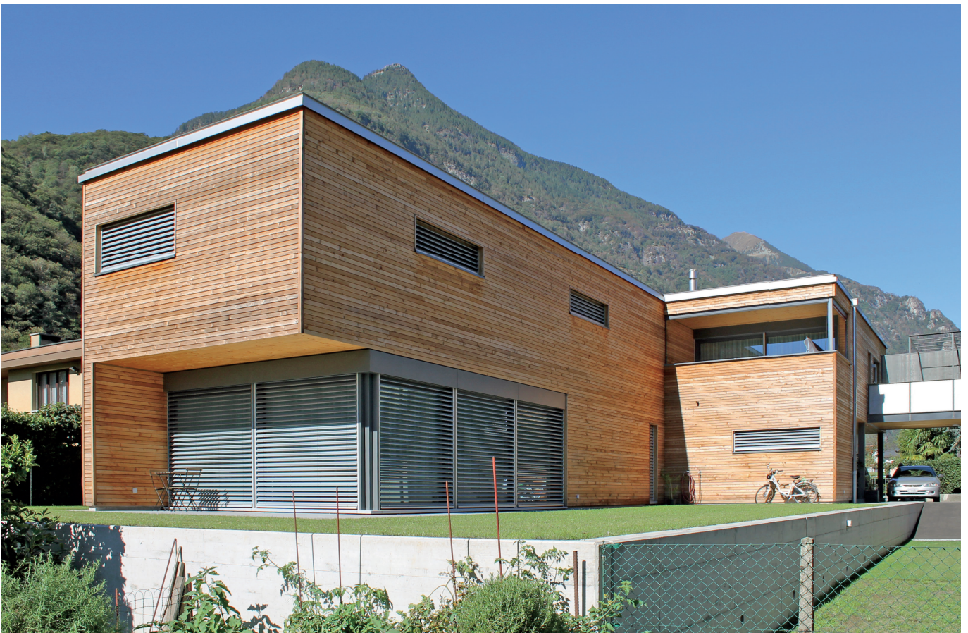
Das Zweifamilienhaus aus Südosten gesehen
