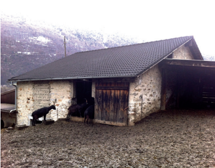
Das Gebäude in seiner früheren Funktion als Stall
